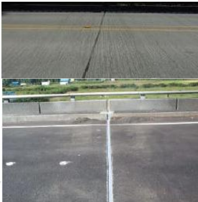
Figure 1 e 2. Esempi dell'Elemento Standard (Washington State Bridge Inspection Manual).
