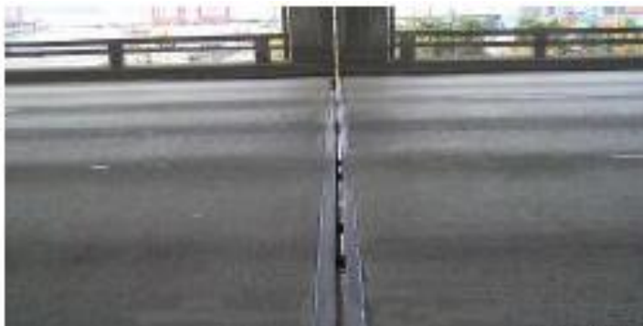
Figure 1 e 2. Esempi dell'Elemento Standard (Washington State Bridge Inspection Manual).
