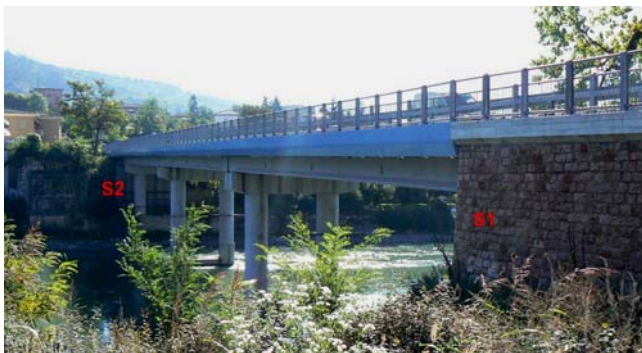
Figura 2. Ponte sul fiume Adige, SP90.
